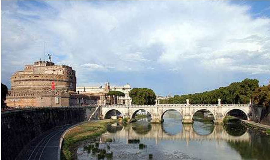
Ponte Elio (ponte Sant'Angelo)
